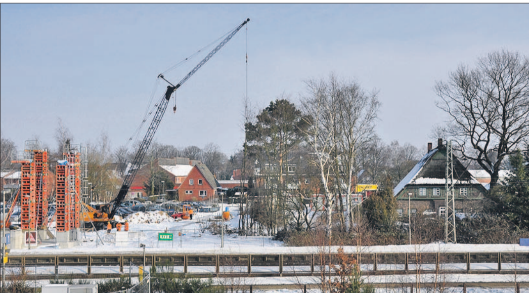
Das 200 Jahre alte ehemalige Altenteilerhaus des Tornescher Hofes liegt direkt neben der aktuellen Baustelle der Fußgängerbrücke über die Bahngleise.
