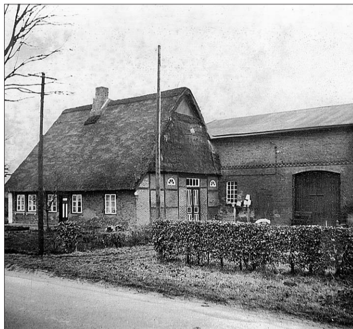
Bauernkate an der Ahrenloher Straße um 1950. Das um 1844 erbaute Haus ist eines der ältesten in Ahrenlohe, erbaut wurde es vom Tagelöhner Tewes Semmelmann. Die Außenwände des kellerlosen Hauses stehen auf Findlingen. Rechts ein gründerzeitlicher Anbau, wie ihn viele Höfe vor dem Ersten Weltkrieg in wirtschaftlich günstiger Zeit erstellten. Nach dem Krieg wurde die Landwirtschaft von der Familie von Hellms weiter im Nebenerwerb betrieben, zunächst mit sieben, nach 1970 noch mit zwei Kühen bis Anfang der 1980er Jahre. Foto: Claudia Möller
