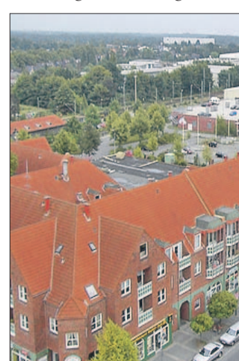
Der Wohn- und Gewerbekomplex „Tornescher Hof“ und die „Alte Brennerei“ im Jahr 2003. Von den ehemaligen Brennereigebäuden stehen nur noch die im Hintergrund an der Straße gelegenen beiden Backsteingebäude. Foto: Thorsten Berndt, Archiv Kulturgemeinschaft
